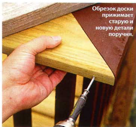
Разметьте скос на новом поручне, пользуясь старым как шаблоном.
